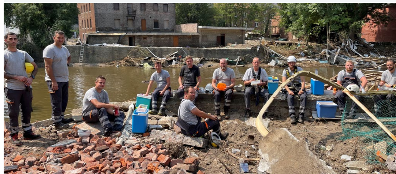
FIGURE 1.11: INONDATION D'UN POSTE À HAUTE TENSION SUITE AUX PLUIES EXTRÊMES DE JUILLET 2021
