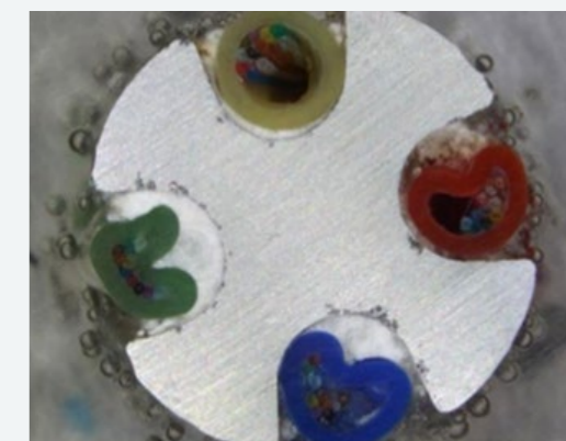
Coupe transversale du jonc d'aluminium, beaucoup de résidus de corrosion viennent déformer les assemblages.
